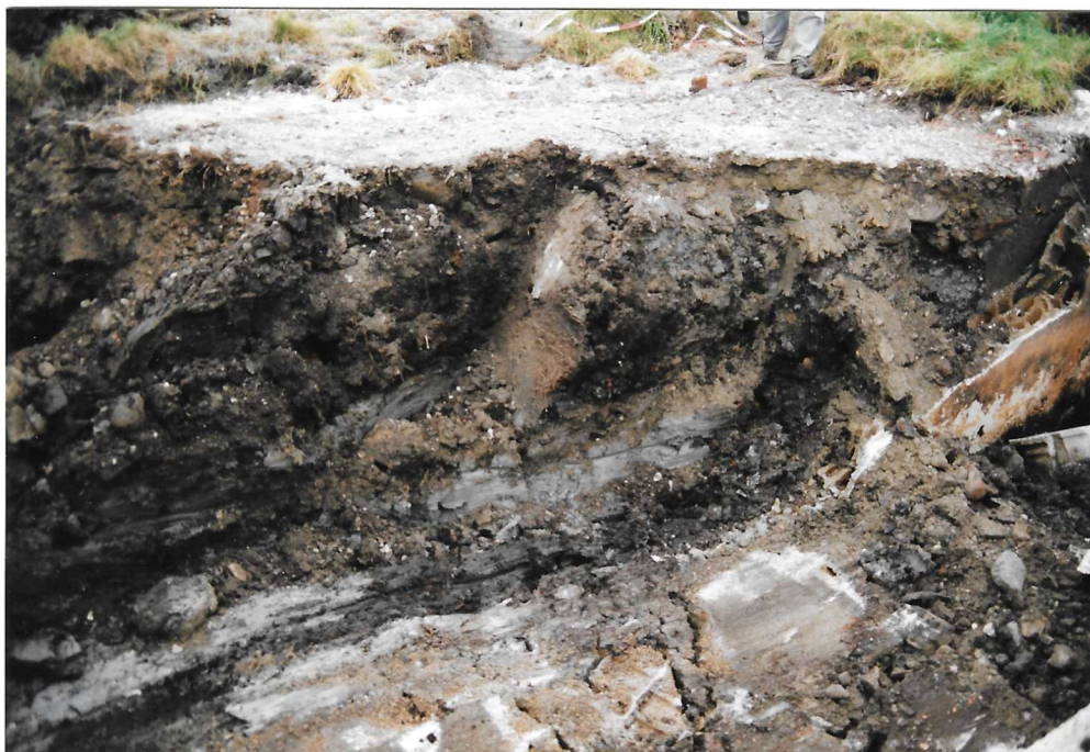
Foto 5: In ca. 1,5 m Tiefe ist unter aufgefülltem Bodenmaterial der anstehende hellgraue Ton erkennbar (nördl. Wand der Baugrube)
