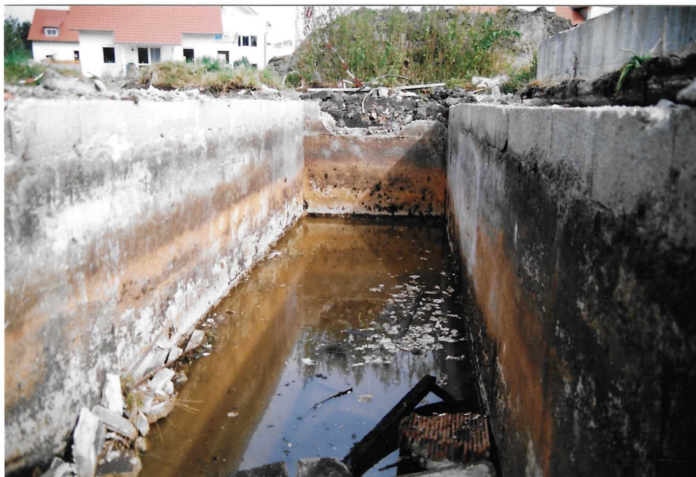
Foto 3: Gemauerte Wanne nach Tankausbau (Blick Richtung Osten)
