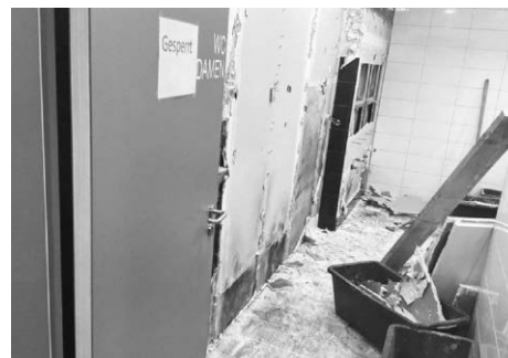
Bild vom Rückbau der WC-Anlagen im Untergeschoss
